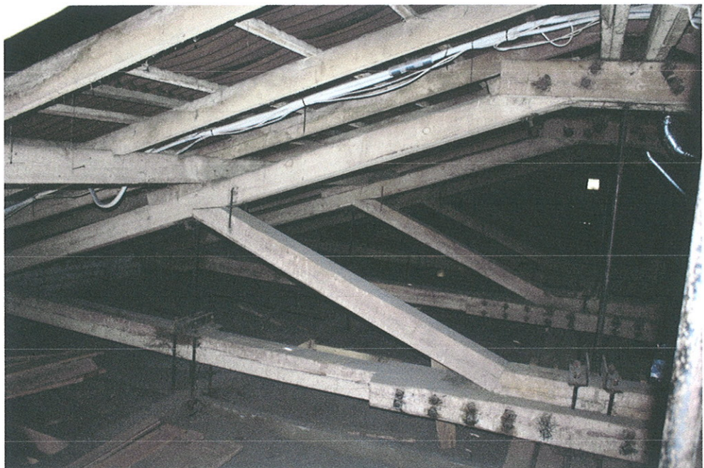
6.att. jumta nesošās konstrukcijas
